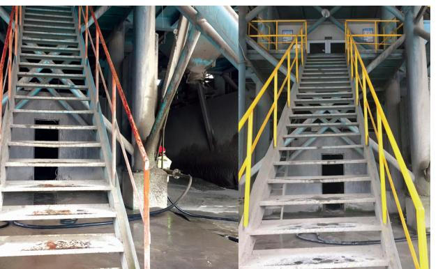
本报讯 近日,混凝土公司在例行日常安全检查过程中,发现公司主机楼部分钢结构因年限已久,腐蚀严重,存在安全隐患。经公司批准,生产部立即联系专业的除锈防腐厂家进行维修,
